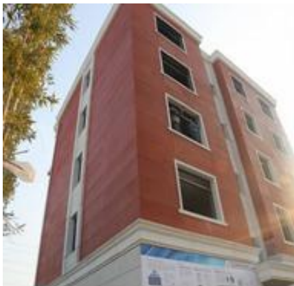
Рисунок 6.2 – Будинки, надруковані на 3D-принтері Шанхайською компанією WinSun (Шанхайская, 2015)
