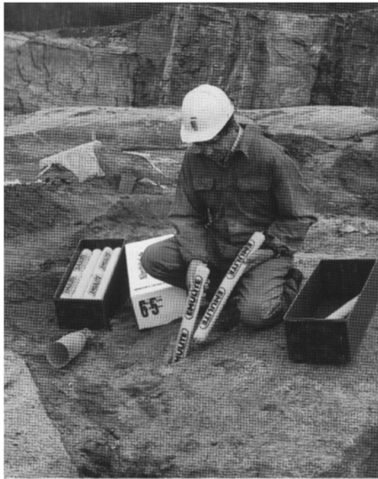
Рисунок 3.15 – Заряджання свердловин емульсійними ВР: а – в пластикових патронах; б – методом наливання
