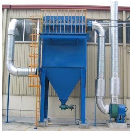
Рисунок 3.5 - Рукавний фільтр
