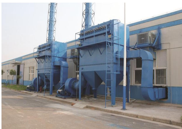
Рисунок 3.3 - Мультициклонна установка
