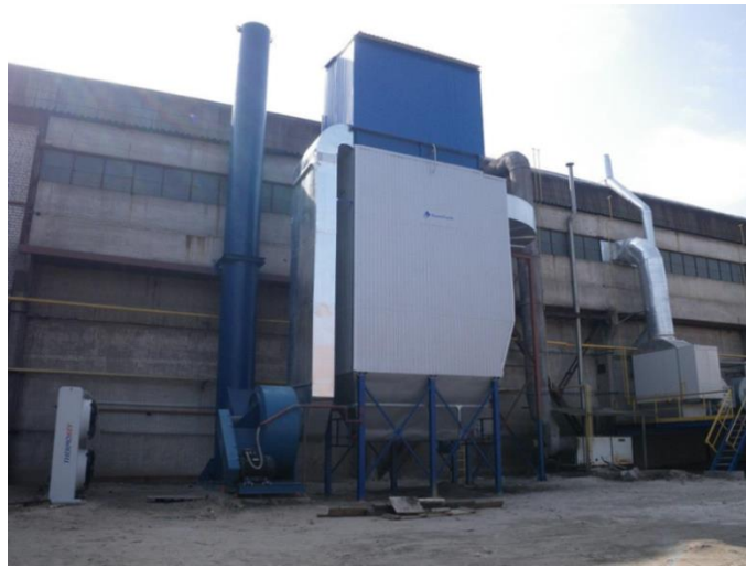
Рисунок 2.9 - Рукавні фільтри
