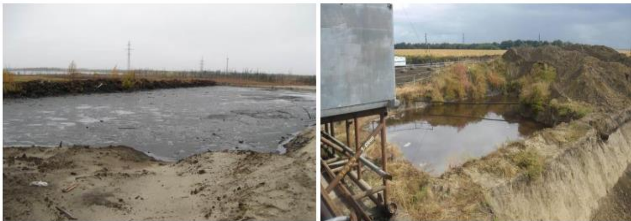
Рисунок 1.1 - Шламіві амбари, як джерело забруднення ґрунтового покриву, поверхневих та підземних вод
