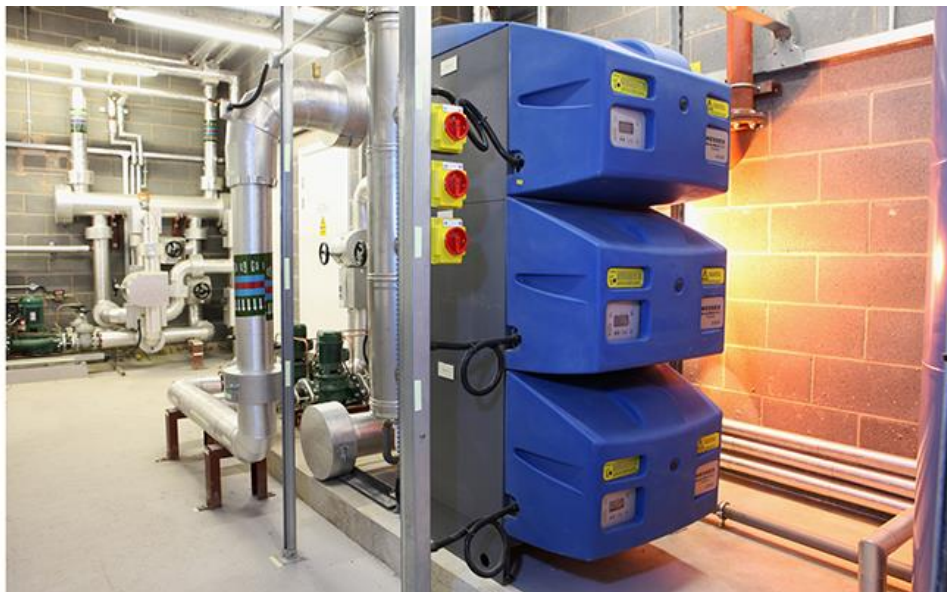
Рисунок 1.3 – Котел водяний одноконтурний газовий конденсаційний із закритою камерою згоряння типу WESSEX MODUMAX 250/750c
