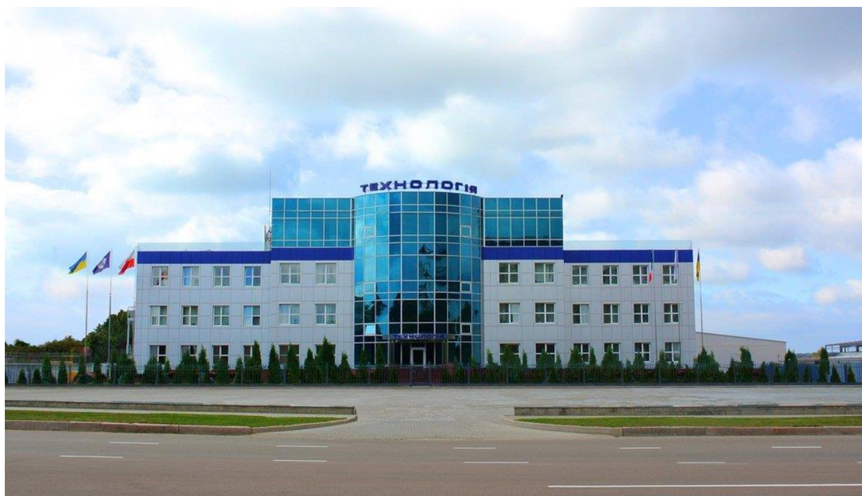
Рисунок 1.1 – Адміністративна будівля ПАТ «ТЕХНОЛОГІЯ»
