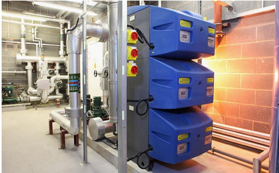
Рисунок 1.5 – Котел водяний одноконтурний газовий конденсаційний із закритою камерою згоряння типу WESSEX MODUMAX 250/750c
