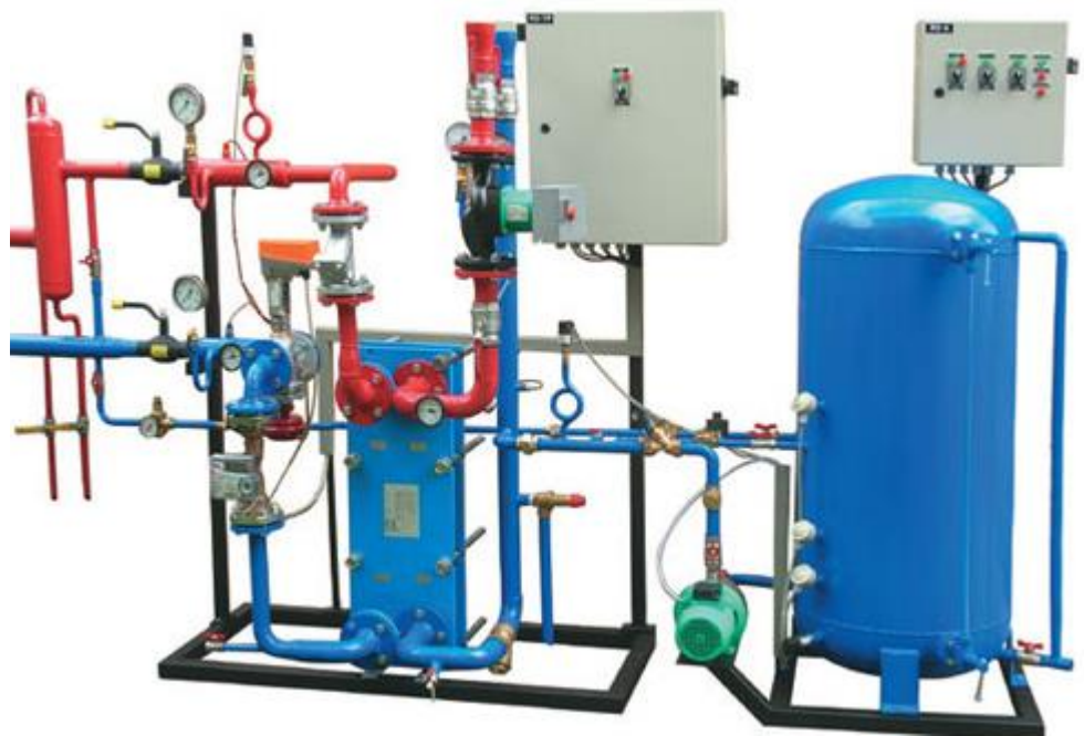
Рисунок 3.1 – Зовнішній вигляд ІТП [18]
