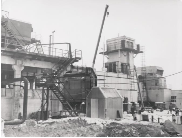
Рисунок А.33 – Випробування компресора надвисокого тиску на експериментальному стенді ВНДІкомпресормашу
