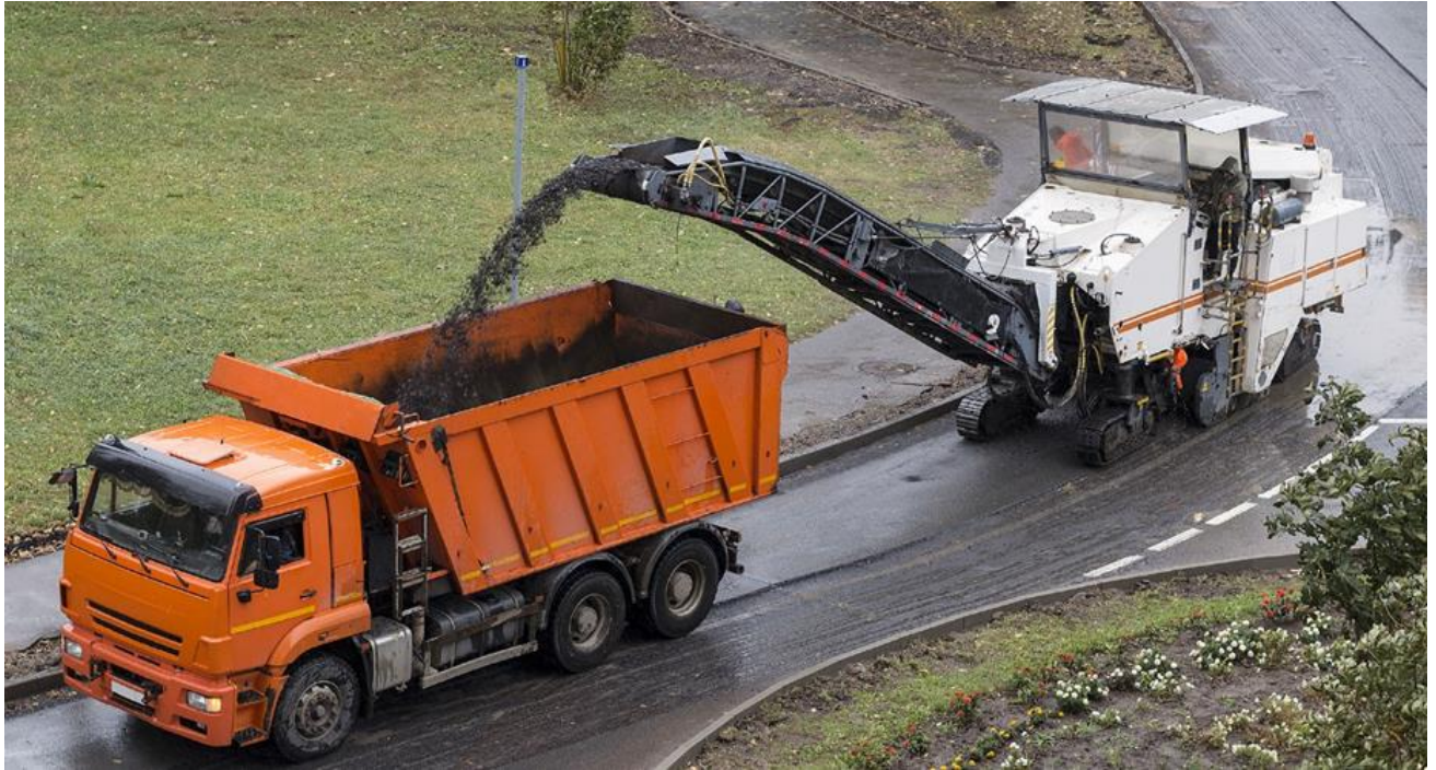
Рисунок 2.4 – Подрібнення асфальтобетонного брухту (фото: https://www.omniamachinery.com/ )
