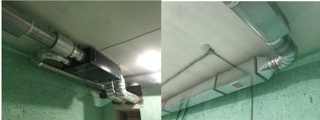
Рисунок 2.1 - Припливно-витяжна вентиляція з рекуперацією
