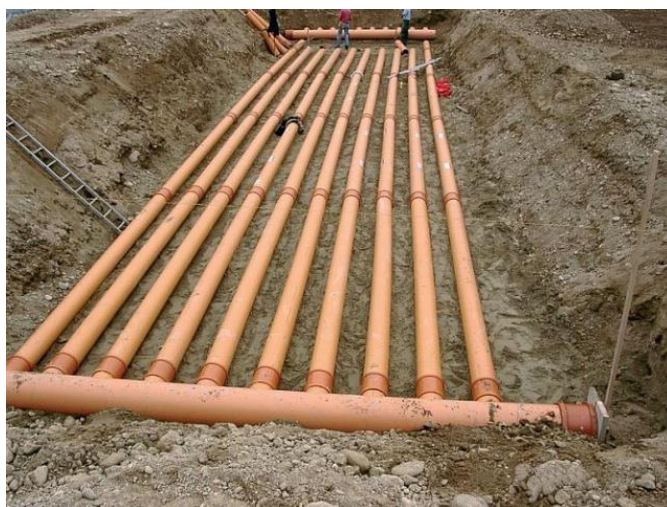
Рисунок 4.6 – Труби для збирання підземного тепла/прохолоди (Закопана, 2015)
