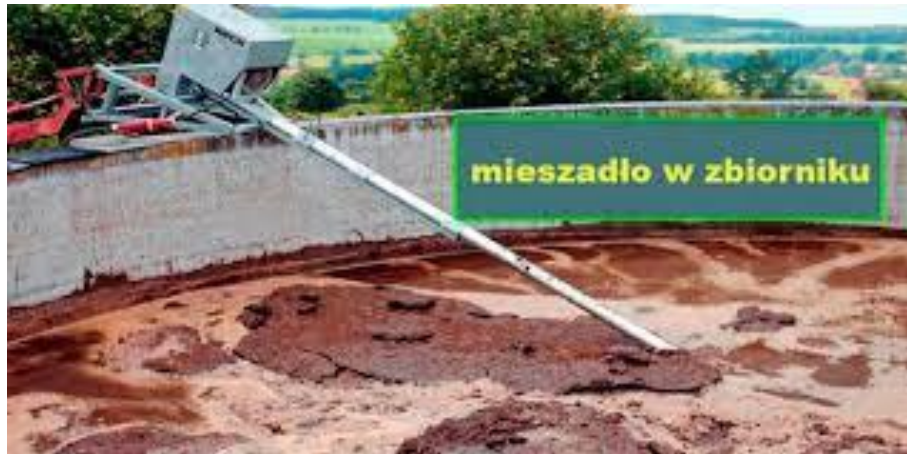
Рисунок. 3.11– Похила механічна мішалка
