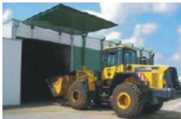
Рисунок 3.2 –Гаражна конструкція ферментаторів для сухого періодичного бродіння [36]
