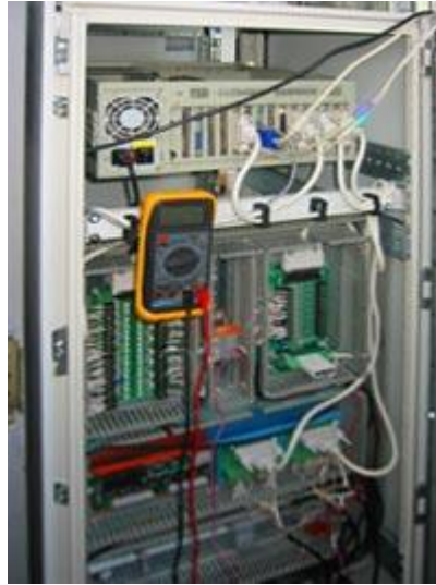
Рисунок 33 – керуючий комплекс АСУТП на базі шафи Rittal
