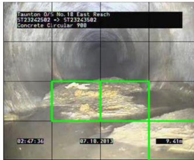
Рисунок 1.14 – Розбиття зображення відеоінспекції на патчі для роздільного аналізу
