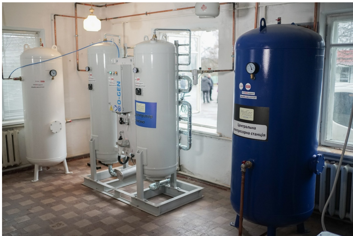
Рисунок 1.2 Установа генерації медичного кисню
