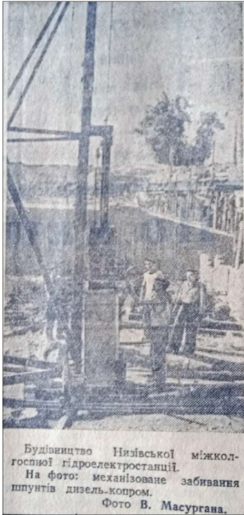
Фото 4. Фрагмент газети «Більшовицька зброя» від 27 липня 1951 р. зі світлиною будівництва Низівської міжколгоспної ГЕС [8, с. 2]
