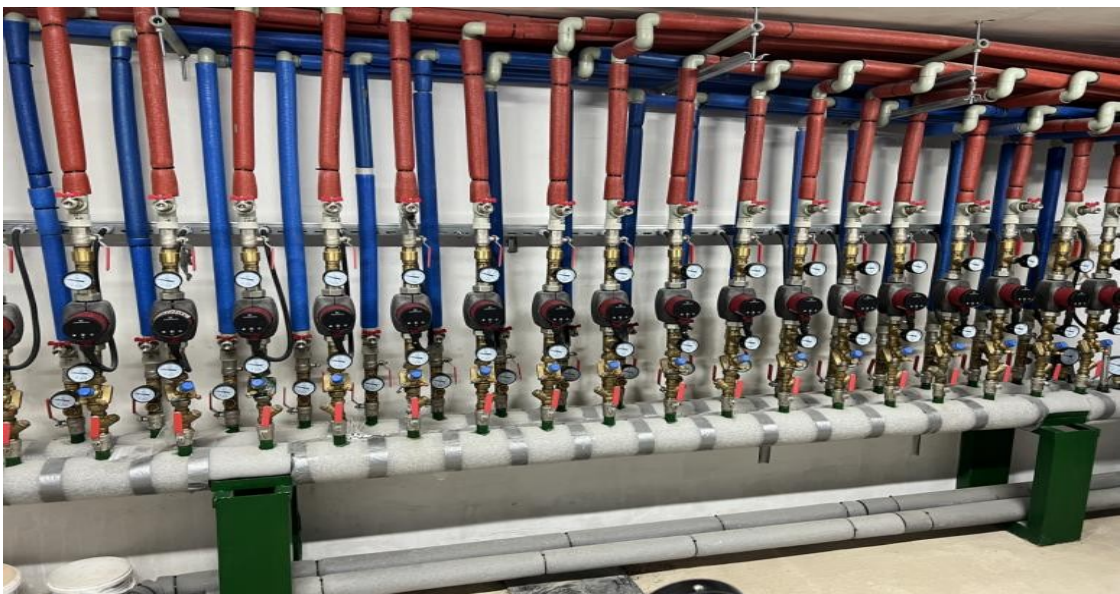
Рисунок Г.1 - Теплопункт в підвальному приміщенні
