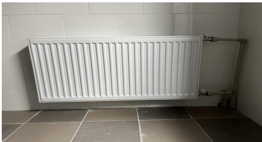
Рисунок 1.2 - панельні конвектори
