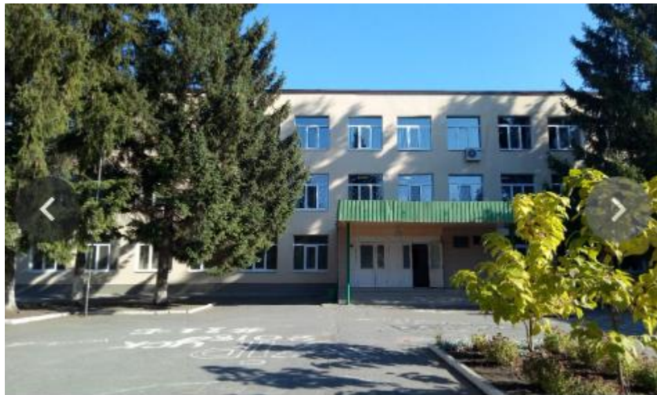
Рисунок 1.1 – Головний фасад будівлі
