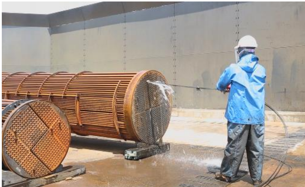
Рисунок 1.12 – Профілактика очистки трубок
