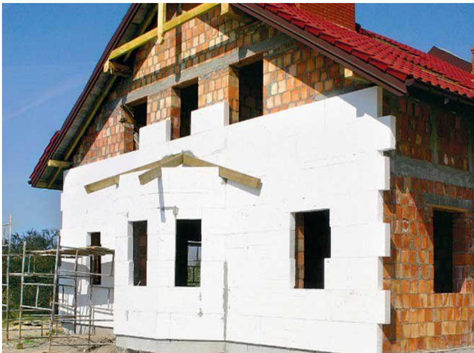
Рисунок 7. Приклад утеплення будинку
