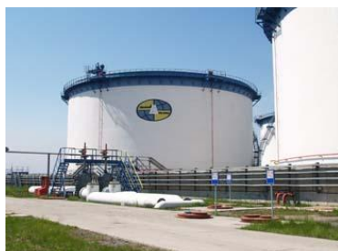
Рисунок 21.15 – Зазвичай резервуари пофарбовані білою або алюмінієвою фарбою
