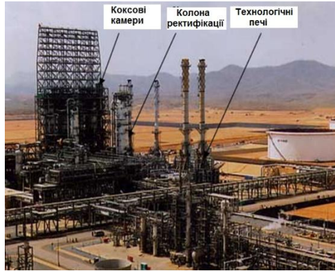
Рисунок 8.7 – Розташування коксових камер, колони ректифікації та технологічних печей на сучасному НПЗ
