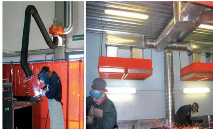
Рисунок 5.1 – Промислова вентиляція: а – місцева; б – загально обмінна
