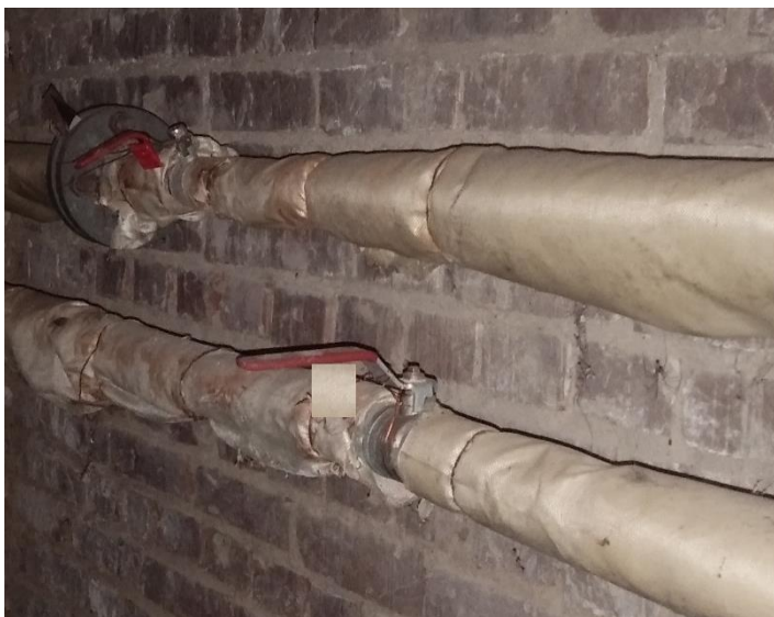
Рисунок 1.2 – Стан трубопроводів системи теплопостачання
