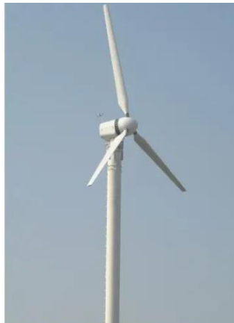
Рисунок 2.4 – Вітрогенератор FLAMINGO AERO WES-20 (20 кВт) з мережевим інвертором (20 кВт) [27]
