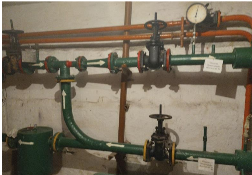
Рисунок 1.2 – Елеваторний вузол системи теплопостачання
