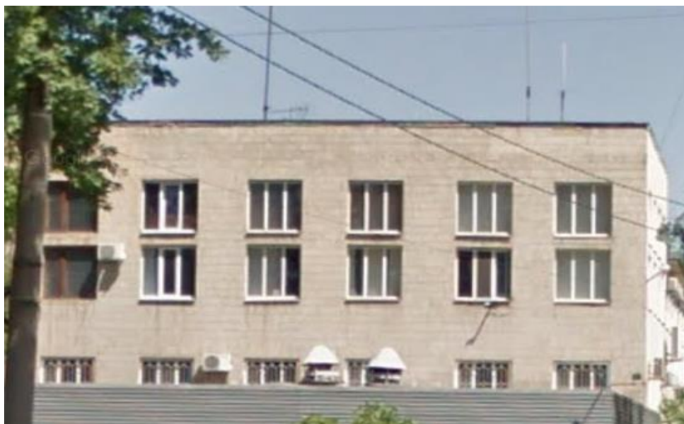
Рисунок 1.1 – Зовнішній вигляд фасаду будівлі «Універсал-Сервіс»
