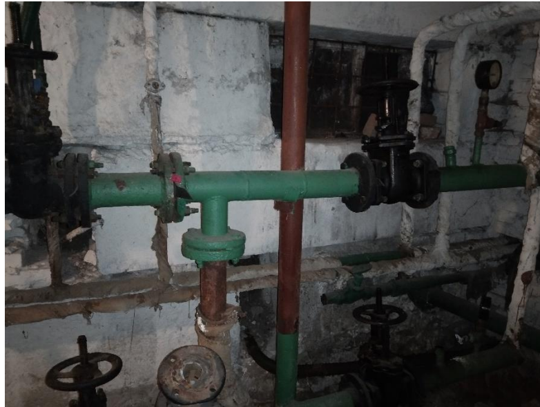
Рисунок 1.2 – Елеваторний вузол системи опалення
