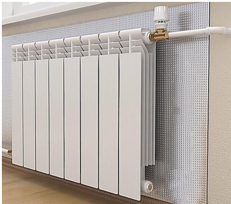
Рисунок 2.2 – Встановлення зарядіаторних тепловідбивних екранів
