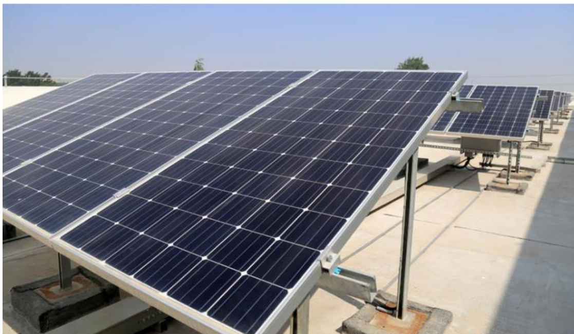
Рисунок 2.2 – Принцип встановлення сонячних панелей на даху будівлі [15]
