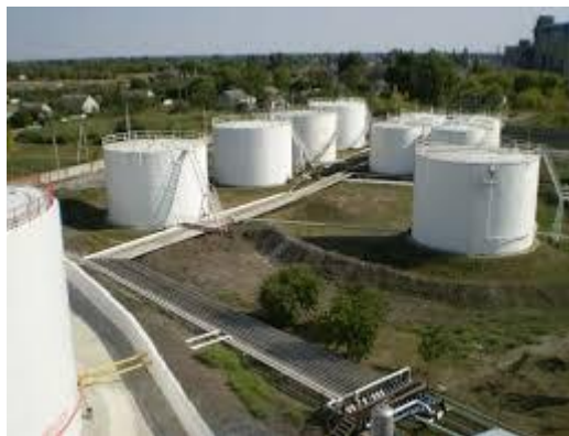
Рисунок 3.1 - Приклад резервуарів для зберігання нафтопродуктів
