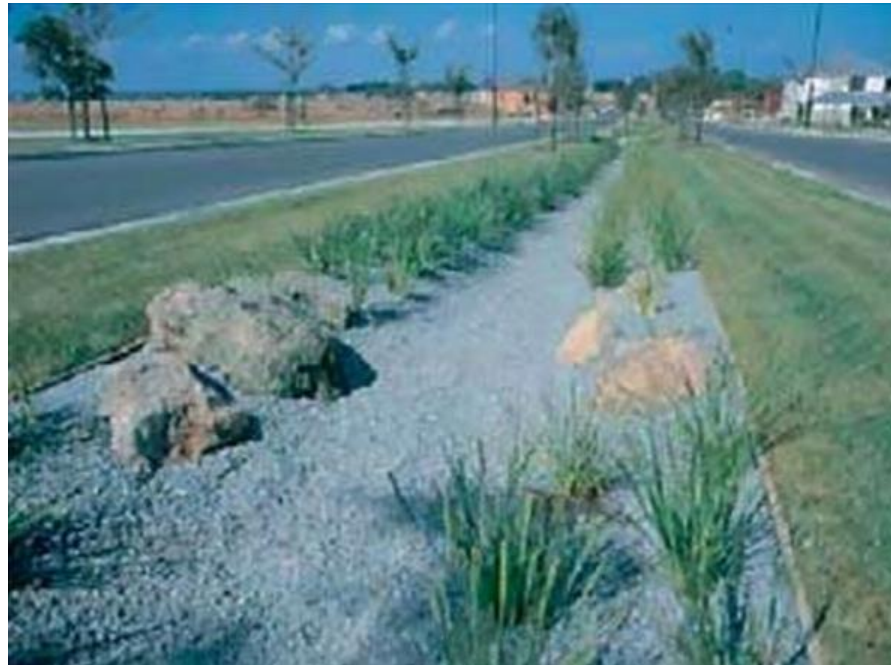
Рисунок 2.3 – Біофільтраційна система для очищення поверхневих стічних вод з автомобільної траси [21, с. 230]
