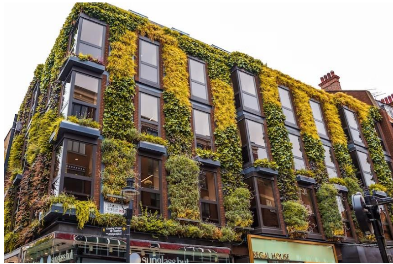
Рисунок 2.1 – Приклад фасадного озеленення (джерело: https://visad.com.ua )
