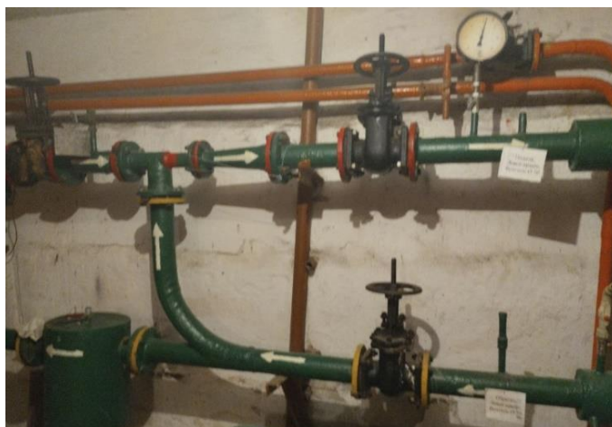
Рисунок 1.2 – Елеваторний вузол системи теплопостачання
