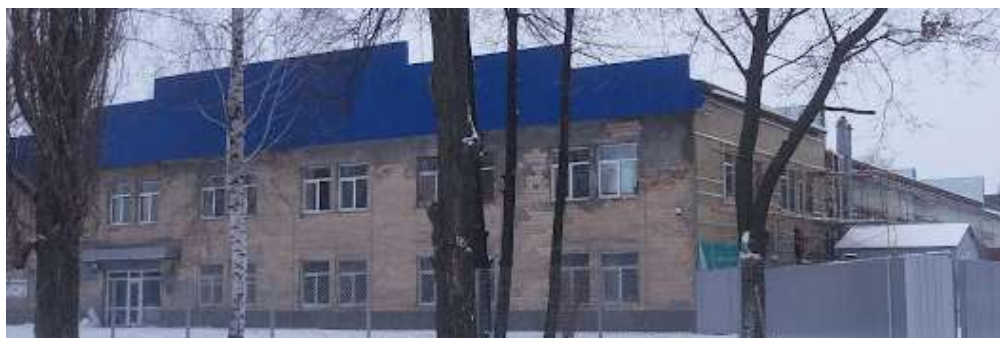
Рисунок 1.1 – Головний фасад будівлі
