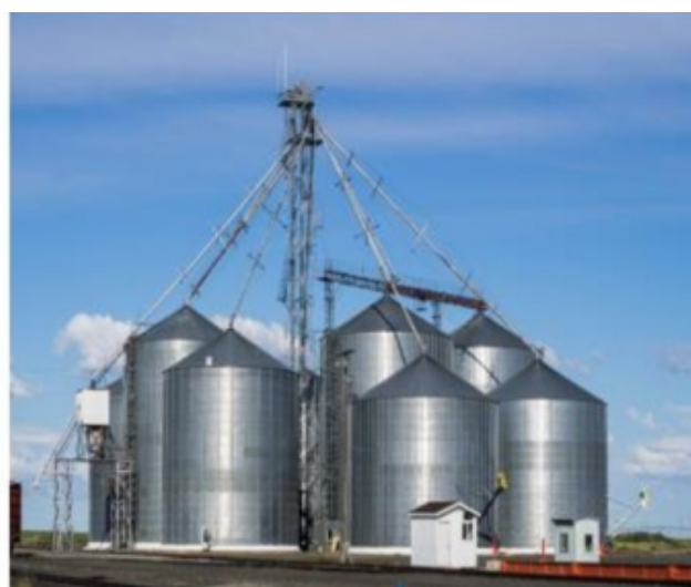
Рисунок 1.1 – Металічні силоси
