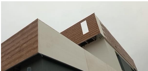
Рис. 1 – Загальний вид оздоблення фасаду магnezитовими панелями з подальшим облицюванням плиткою з полівінілхлориду
