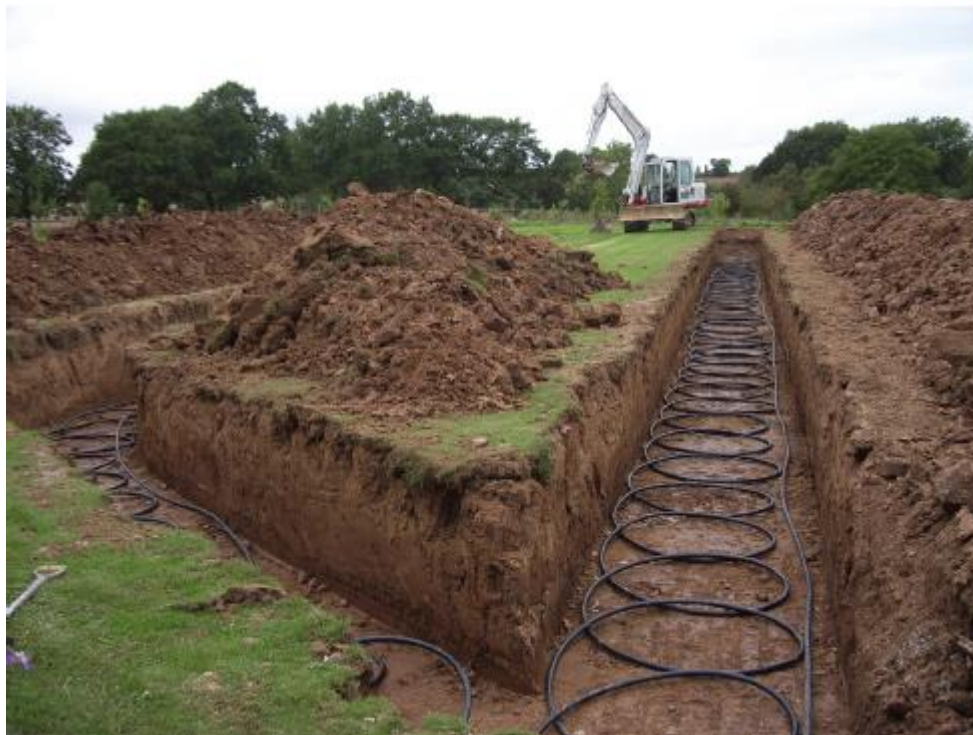
Рисунок 1.3 – Прокладання поліетиленових труб з етиленгліколем для ґрунтового колектора
