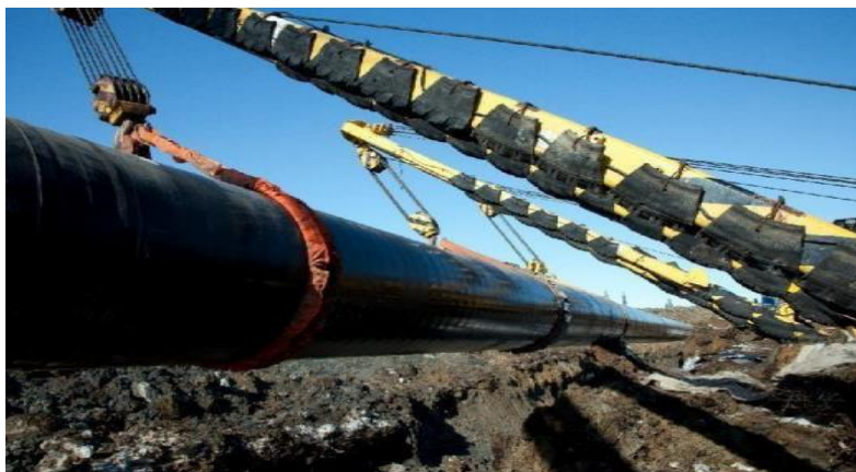
Рисунок 1.1 – Вплив на ґрунтове середовище під час укладання трубопроводів
