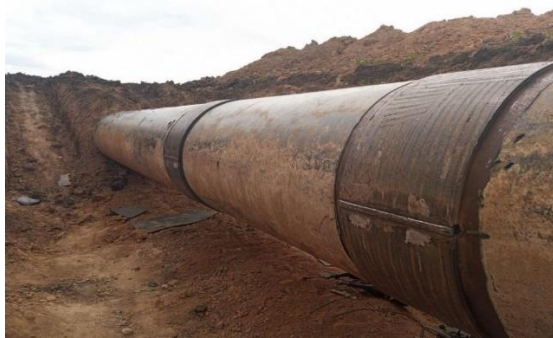
Схема змонтованої муфти КТР4 на трубопроводі «Слець-Кременчук-Кривий Ріг»
