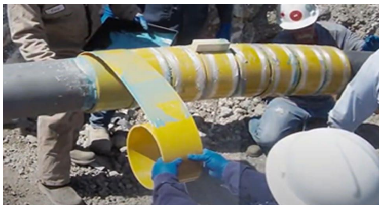
Рисунок 4.9 – Нанесення на дефектну ділянку трубопроводу манжети «Clock Spring»
