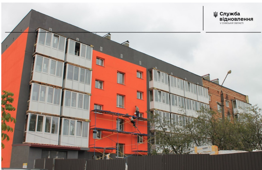
Рис. 2.5 — Вигляд житлової будівлі на фінальному етапі відбудови вул. Благовіщенській, 53 у м. Тростянець
