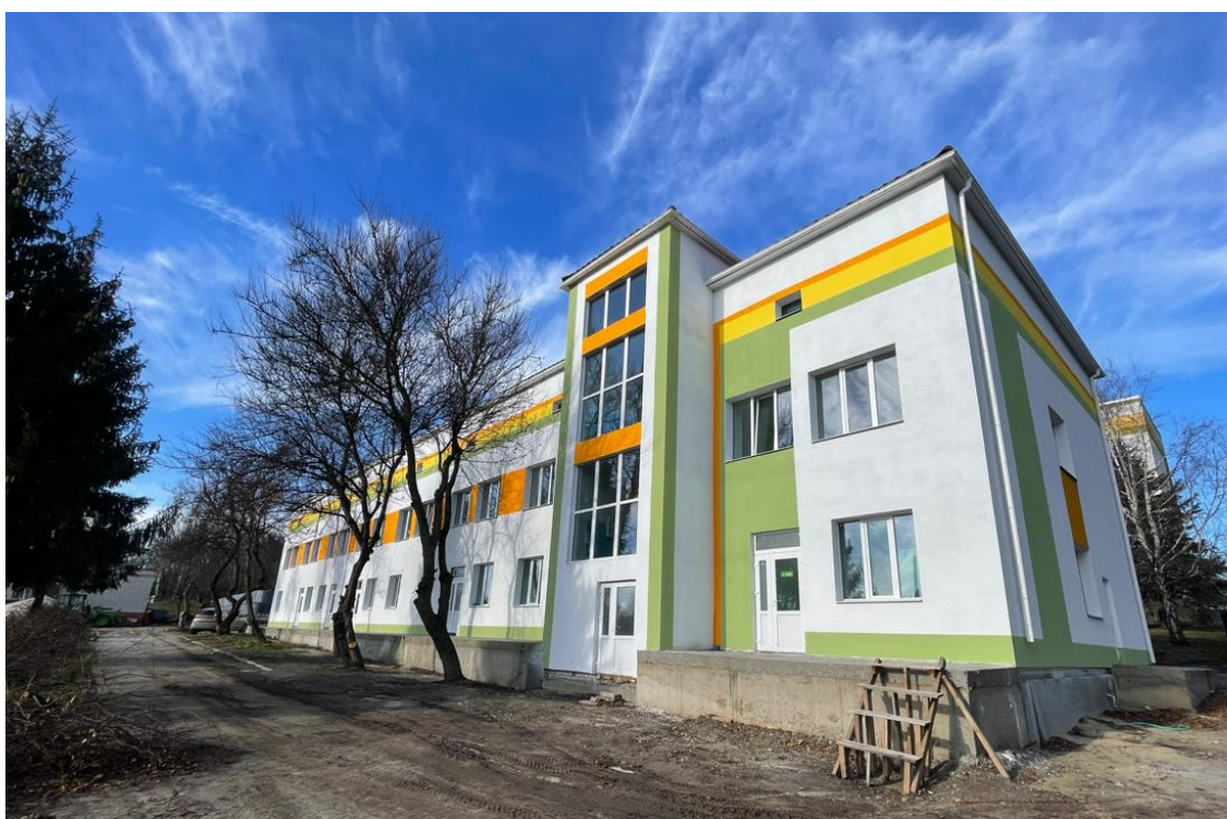
Рис. 3.12 — Архітектурний вигляд інфекційного відділення Тростянецької міської лікарні з лицьової сторони в процесі відновлення (DREAM, 2022)
