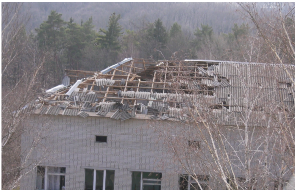
Рис. 3.9 — Стан зовнішнього покриття даху будівлі інфекційного відділення до початку реалізації проєкту (DREAM, 2022)
