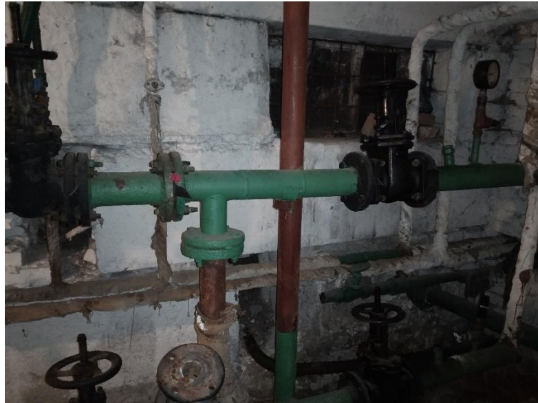
Рисунок 1.2 – Елеваторний вузол системи опалення
