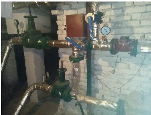
Рисунок 1.2 – Елеваторний вузол системи опалення
