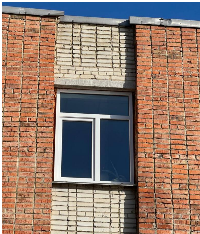
Рисунок 1.2 – Цегляні стіни з металопластиковим склопакетом
