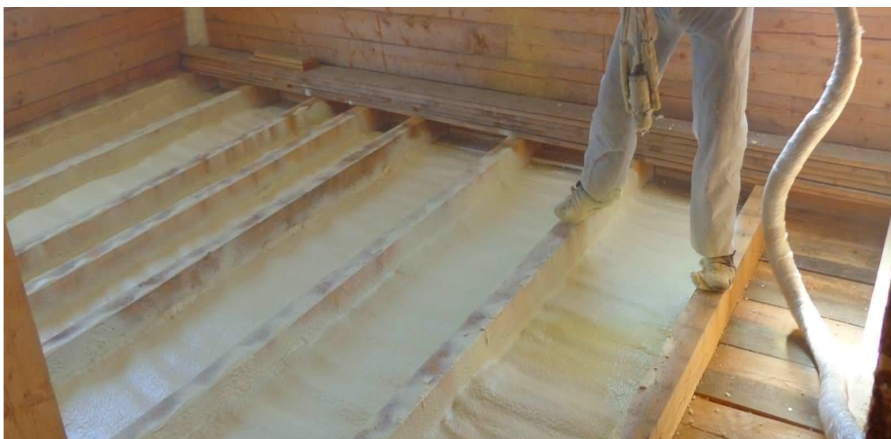
Рисунок 4.3 - Застосування ППУ на підлозі [19]
