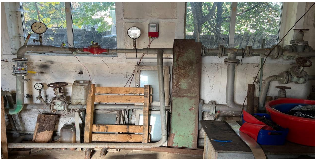
Рисунок 1.3 – Елеваторний вузол системи тепlopостачання
