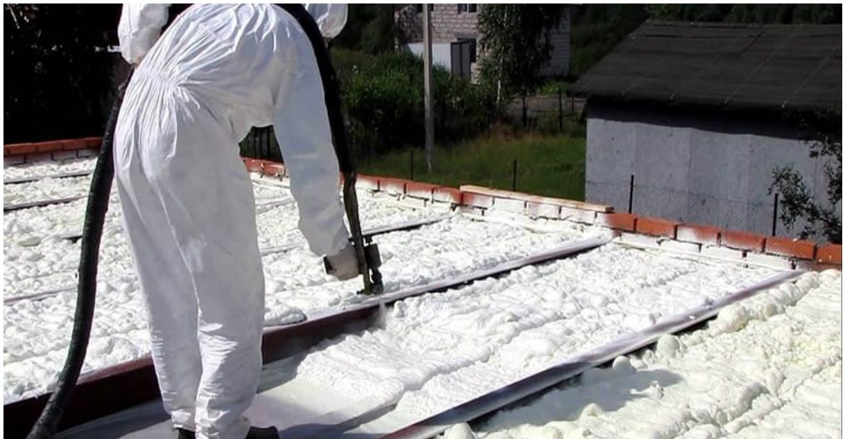
Рисунок 4.2 - Застосування ППУ на даху [17]
