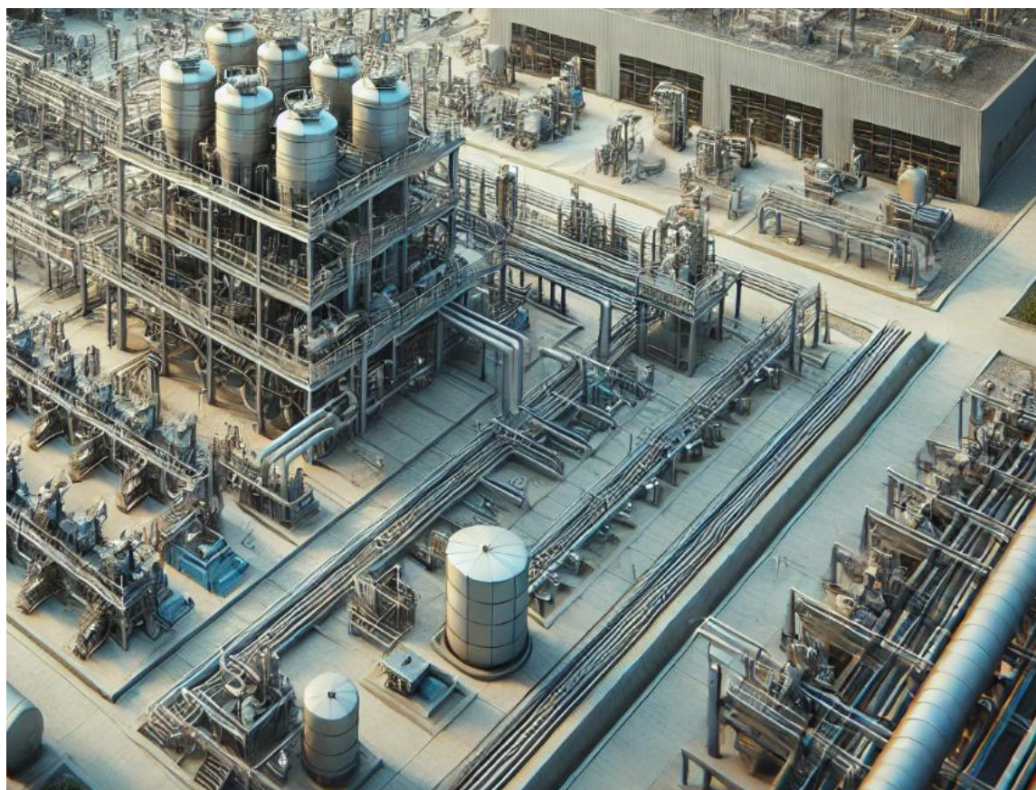
Рисунок 4.1 – Повністю відкритий варіант компонування промислового обладнання, де всі установки розташовані на відкритому майданчику
