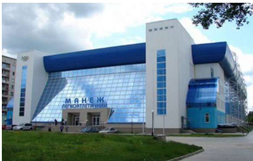
Рисунок 1.1 – Зовнішній вигляд фасаду будівлі Легкоатлетичного манежу
