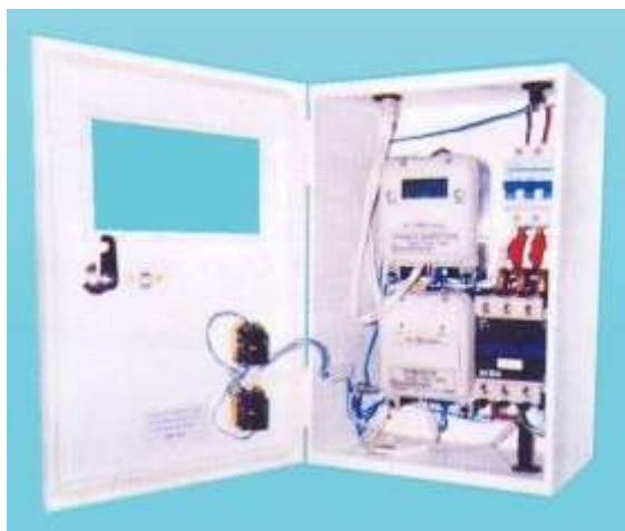
Рисунок 3.5 - Станція автоматичного керування ТГА
