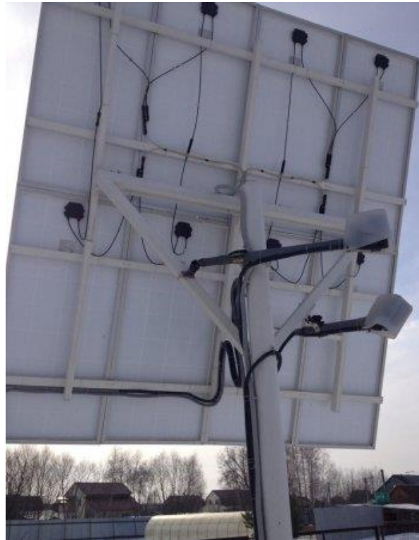
Рисунок 1.16 – Зображення сонячної панелі з встановленими актуаторами
