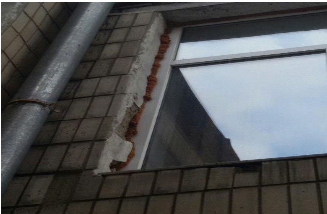
Рисунок 1.3 – Неякісні зовнішні відкоси
