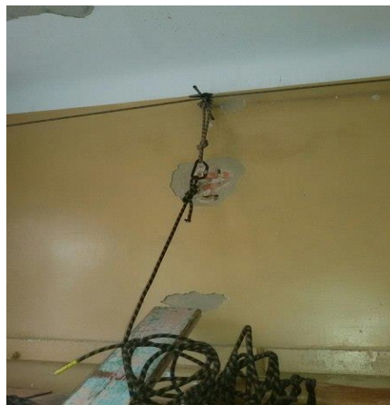
Рисунок 1.5 – Відлушення штукатурки
