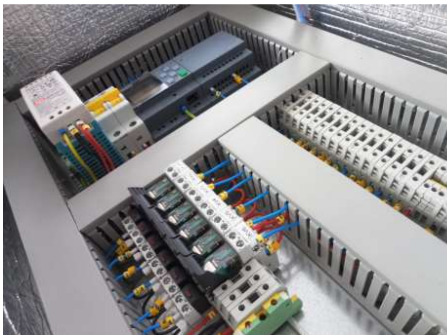
Рисунок 2.6 – Шафа управління експериментальним гідравлічним приводом для синхронних переміщень робочих органів машин
