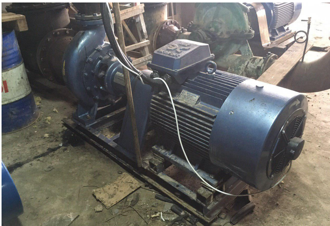
Рисунок 7.8 – Насос АНС 400-25 на ПАТ «Геофіпольський цукровий завод»
