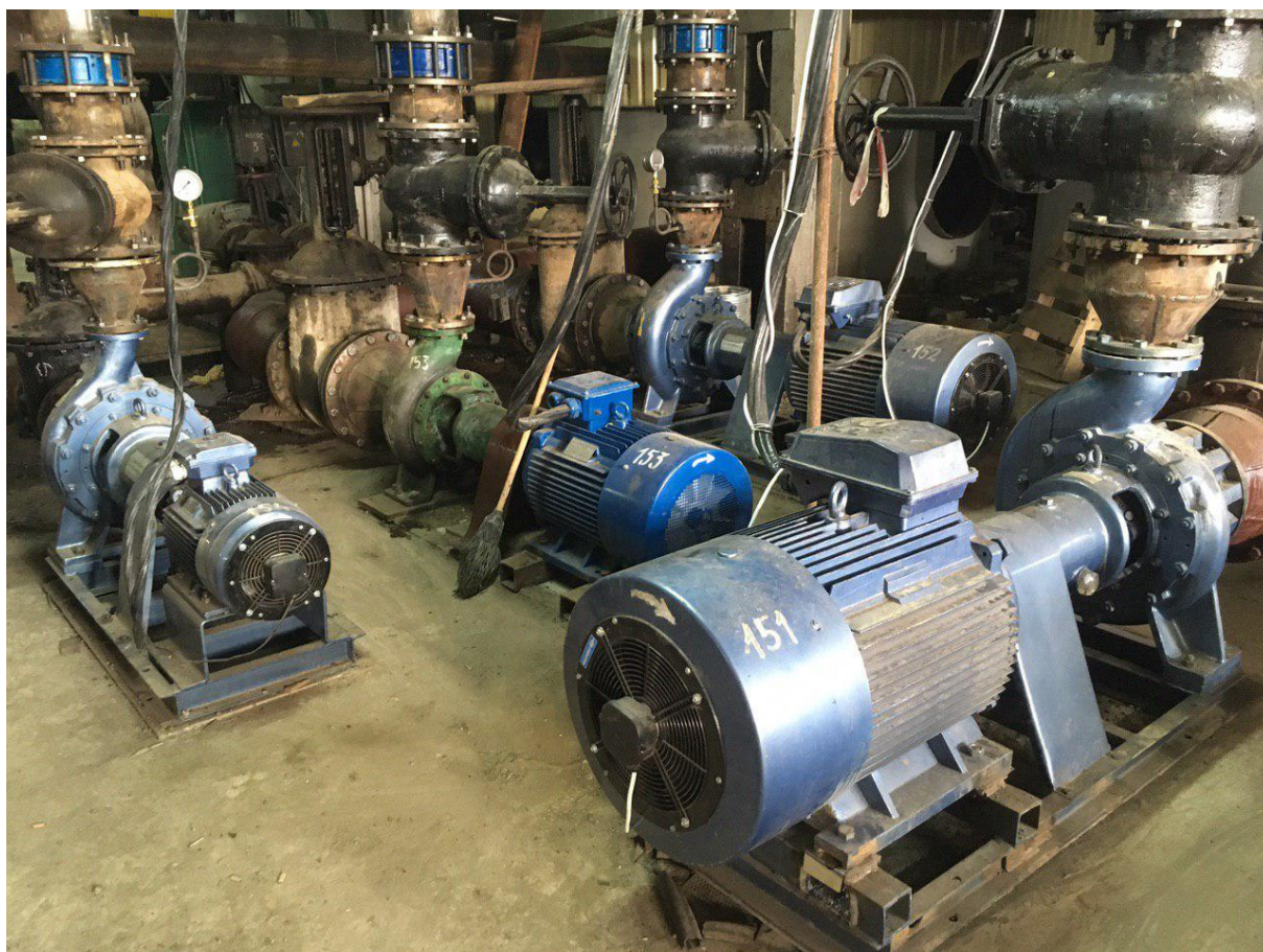
Рисунок 7.9 – Насоси типу АНС виконують технологічні завдання на цукровому заводі
