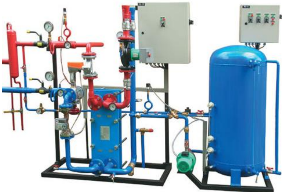
Рисунок 5.1 – Зовнішній вигляд ІТП
