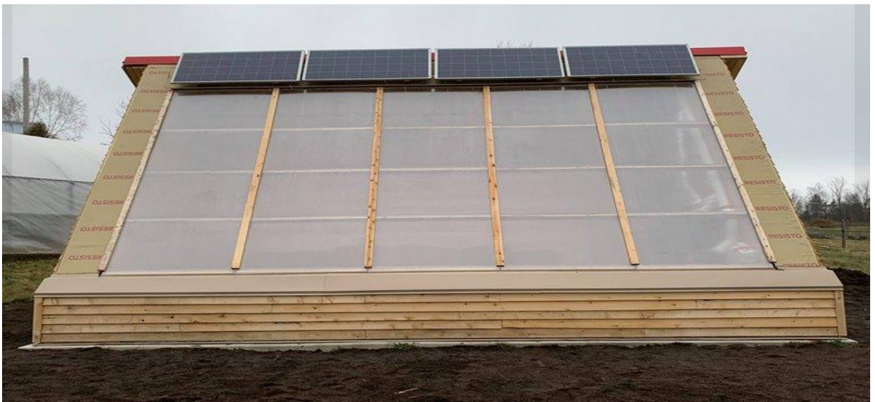
Рисунок 4.9. – Теплиця з сонячними колекторами
