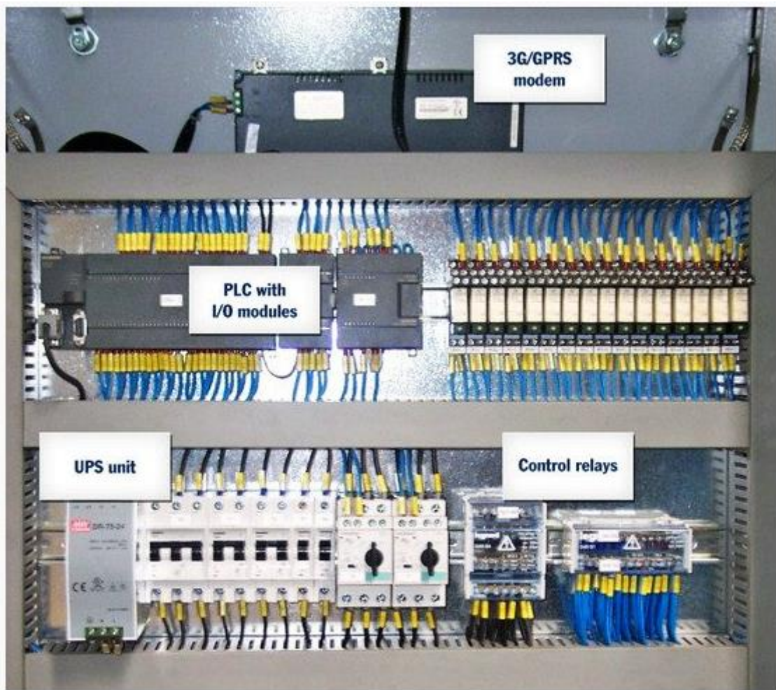
Рисунок 3.5 - Шафа управління з проводами та кнопками на передній панелі ПЛК
